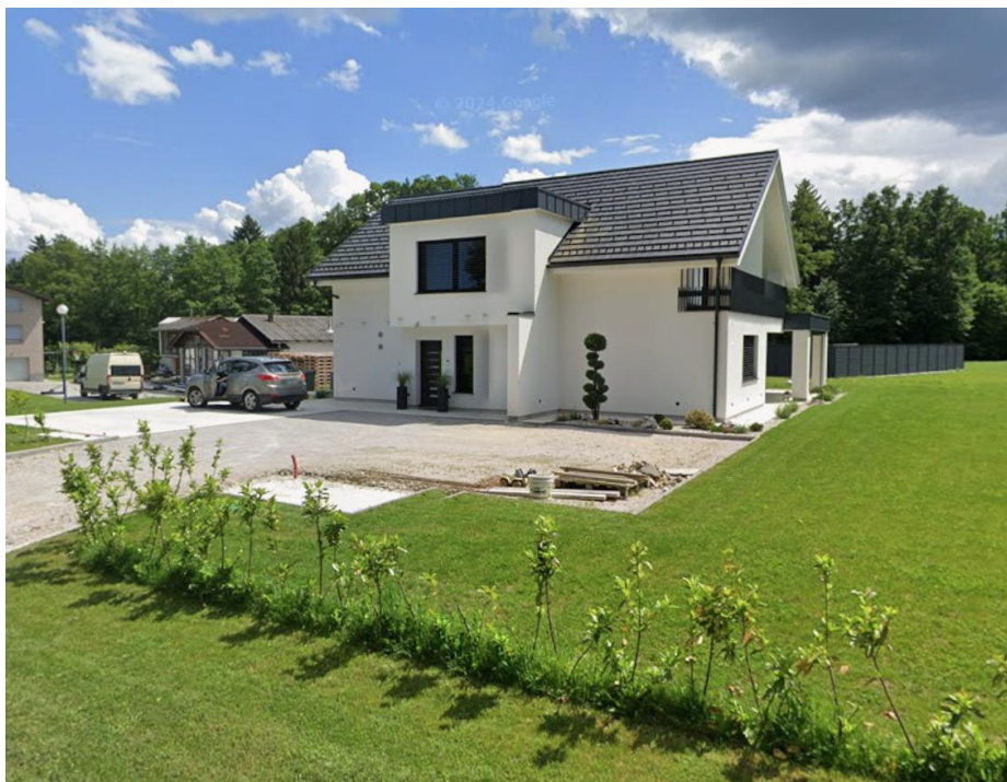
Slika 6: Obstoječi objekt na območju lokacijske preveritve (vir: www.google.com/maps )
