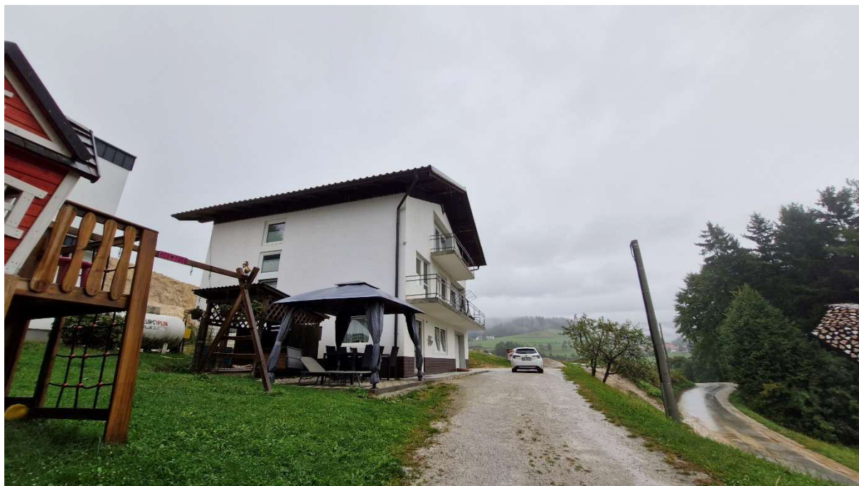
Pogled iz južne smeri na obstoječo stanovanjsko stavbo
