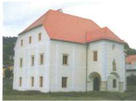
Graščina Oplotnica po obnovi
