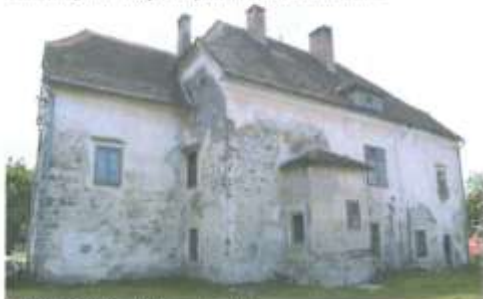
Zahodna fasada graščine pred prenovo
